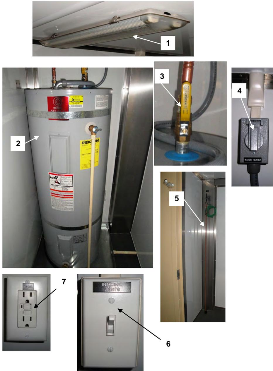
FIGURE 06 CONTAINERIZED SHOWER UTILITY ROOM COMPONENTS
